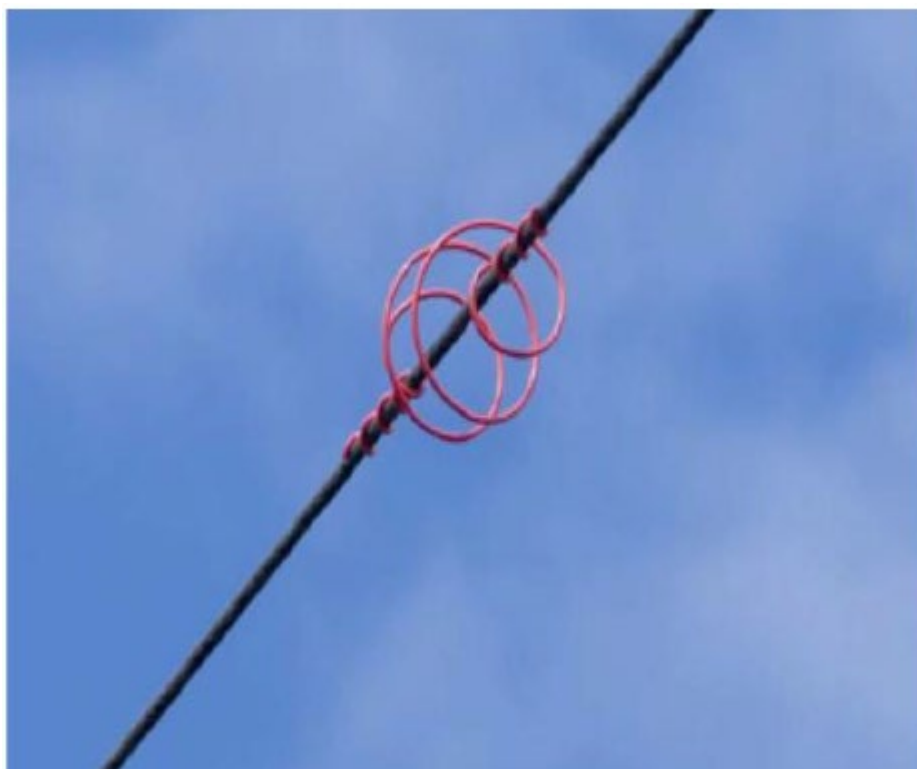
Figura 33 Esempio di segnalatore di cavo
